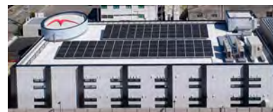
約120枚の太陽光パネルを設置（36kW発電）
